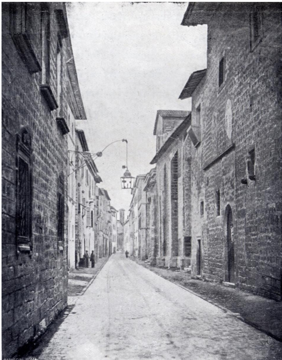
Fabbricato della Scuola prima della sistemazione della nuova facciata
