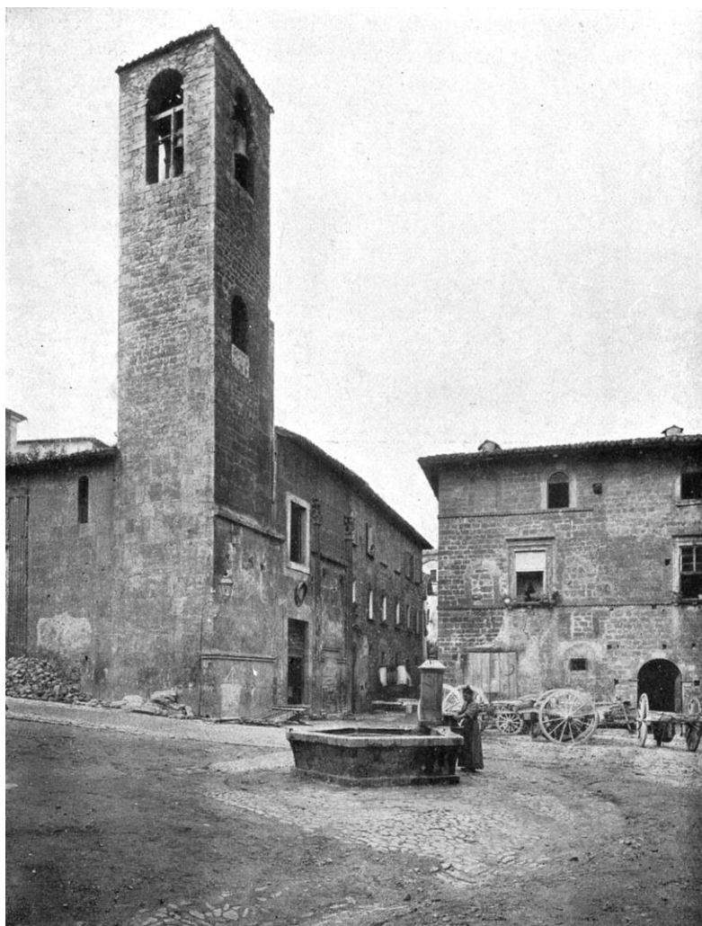
Facciata della Chiesa di San Gregorio prima dell'intervento della scuola
