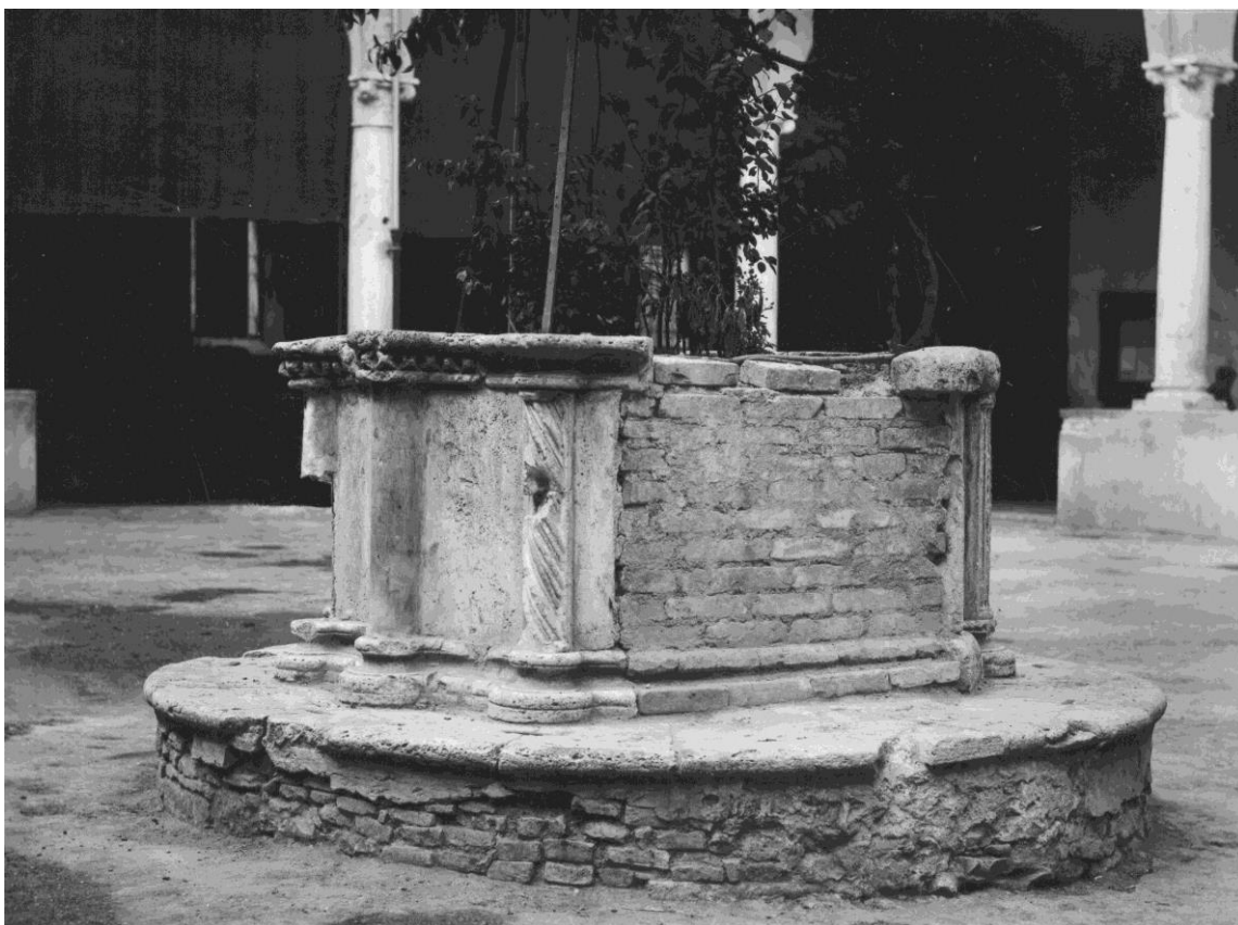
Pozzo del Chiostro Maggiore di San Francesco prima dell'intervento della scuola
